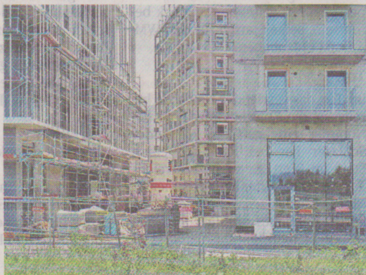
Wie viele Brisen werden brausen? Baustelle Donaufeld. wf
